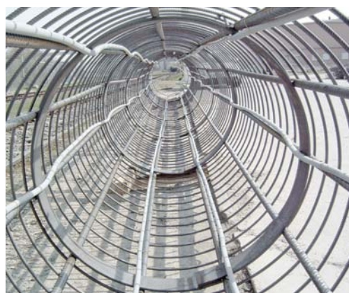
Pilote energético antes de la colocación
