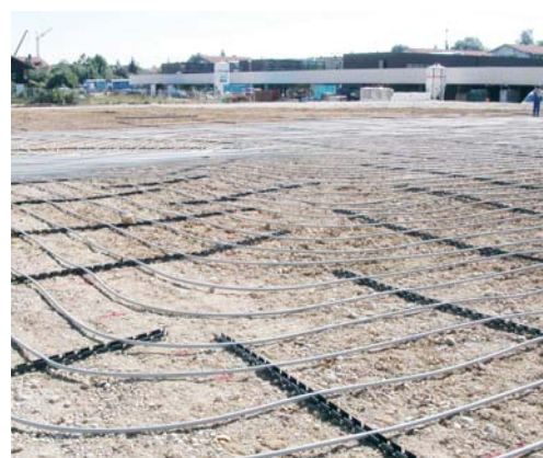
Colocación de los colectores geotérmicos RAUGEO
