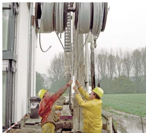
Instalación de una sonda geotérmica RAUGEO
